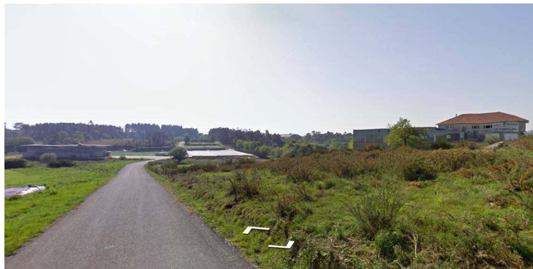
Desubicación de equipamentos ó norte que empeoran a percepción da paisaxe urbana.
